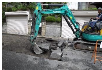
舗装のやり替え工事
