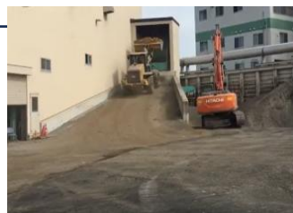
破碎施設投入
