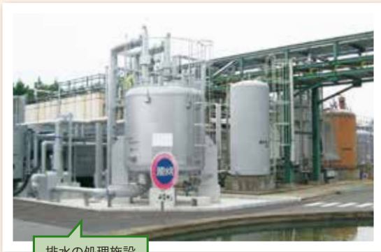
排水の処理施設
