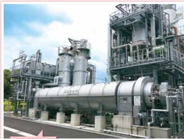
固形燃料化施設
