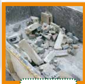
分別されたコンから
