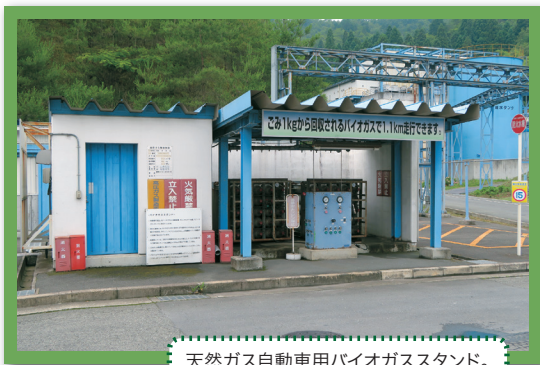
天然ガス自動車用バイオガススタンド。
