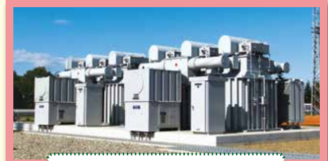
環境配慮設計でコンパクト化された電力用コンデンサ。従来形と比較して総質量を75%に軽量化。また、エネルギー消費量削減も実現。
