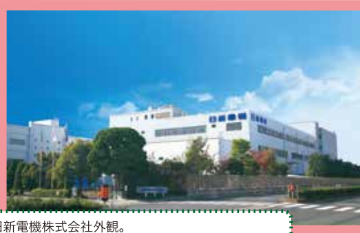
日新電機株式会社外観。 広大な敷地では様々な電気機器が製造されています。
