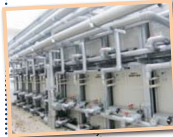
地中熱空調システムの取水ライン
