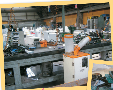
様々な小型家電が解体台上に乗せられ有用物が取り出されている
