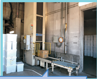
感染性廃棄物のライン。コンベアで上へ搬送され焼却炉に直接投入される
